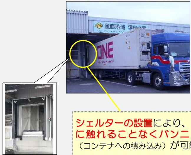
シェルターの設置により、外気に触れることなくバンニング（コンテナへの積み込み）が可能。
