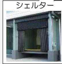
シelterの設置により、外気に触れることなくバンニング（コンテナへの積み込み）が可能。
