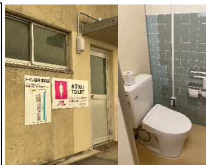
上屋附属事務所 女性トイレの設置
